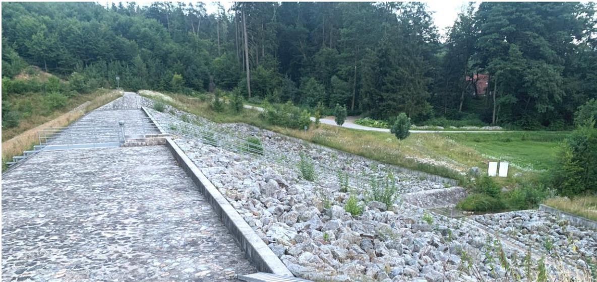
Abbildung 13: Gesicherte Hochwasserentlastungsanlage am HRB Aufroth (Foto: Wagmann Ingenieure GmbH)
