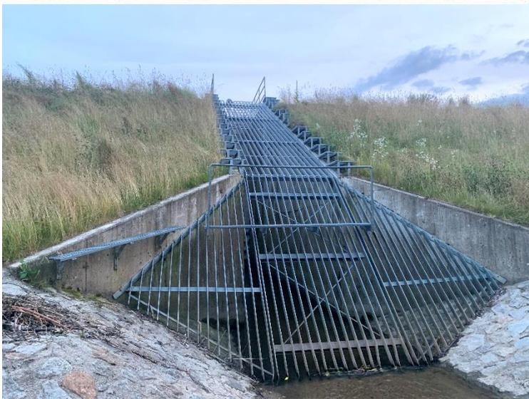
Abbildung 14: Rechen als Kombination aus (Bild oben) dreidimensionalem Grobrechen [DWA-M 522] und (Bild unten) eindimensionaler Abdeckrechen wasserseitig auf der Ökoschlucht (Foto: Wagmann Ingenieure GmbH)
