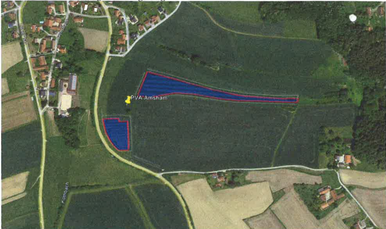
Bild 2.1.2: Detailansicht der PV-Fläche (Quelle: Google Earth/SolPEG)
