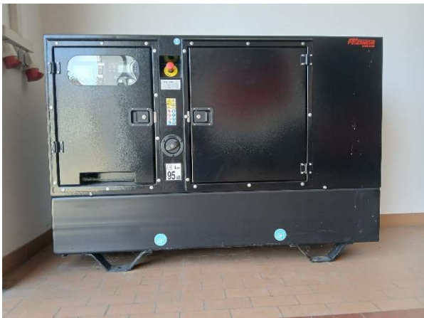
Das Notstromaggregat (20kVA) im Feuerwehrgerätehaus Eggldham
